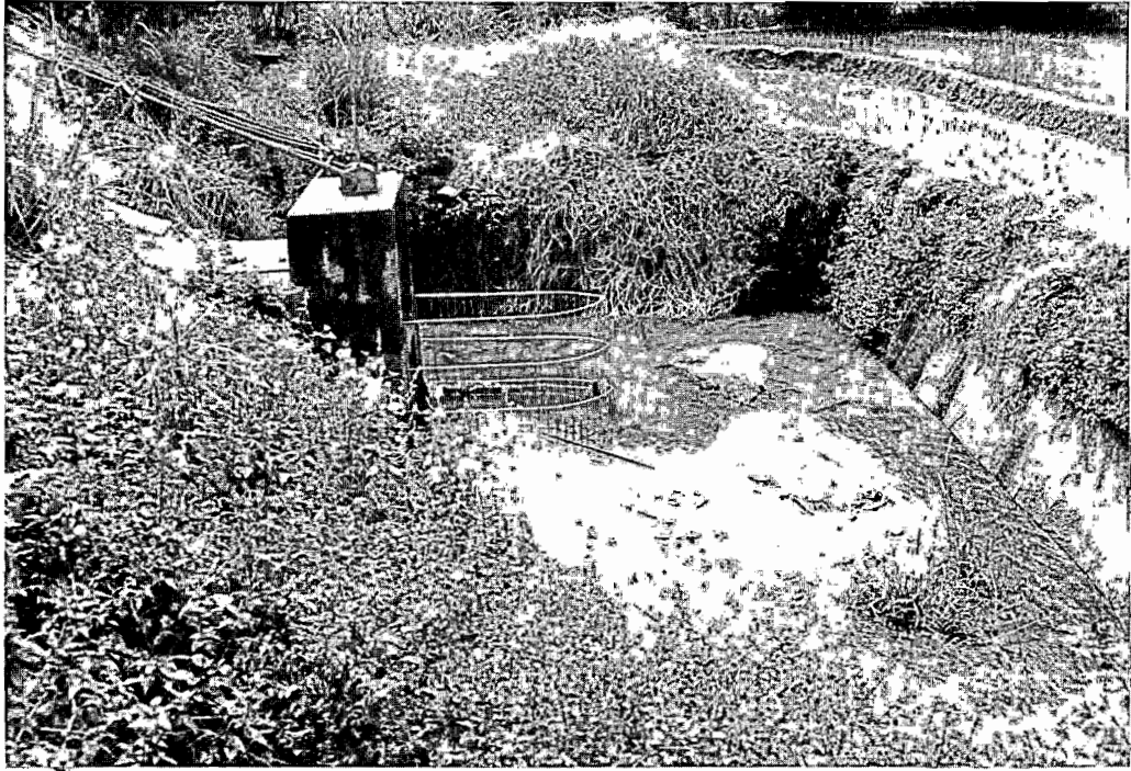
進水口（沉砂池）
