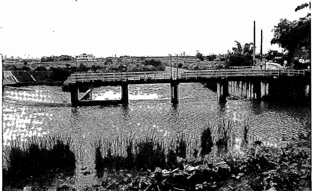
張公圍圳渠首工
