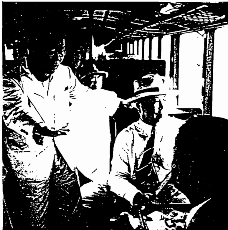
太平渠通水典禮開專車來回工地
