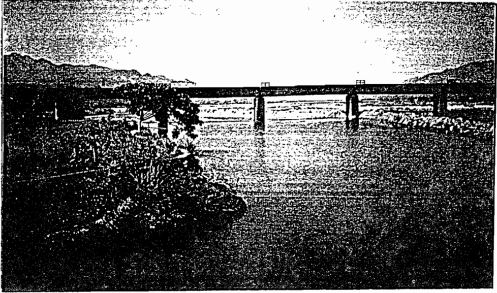
花蓮縣玉里鎮太平渠灌溉導水路及進水口現況
